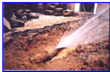
Pesquisa e correção de vazamentos
