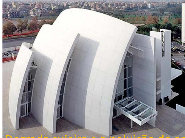
Degrada sujeira e a poluição do ar.
