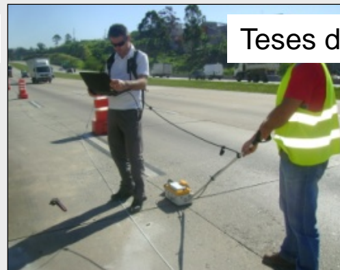
Verificação preenchimento (Georadar )
