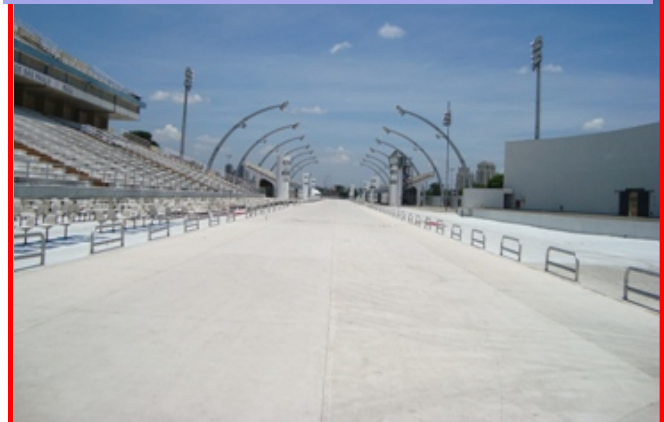
Condição Final do pavimento em concreto
