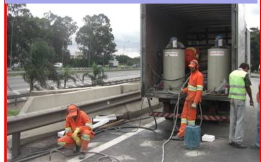
Estabilização de placas bailarinas
