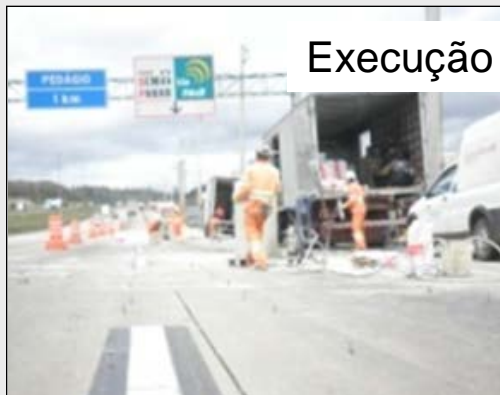
Injeção calda de microcimento
