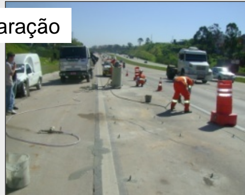
Instalação bicos injetores
