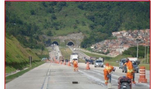
Furação para injeção em base granular
