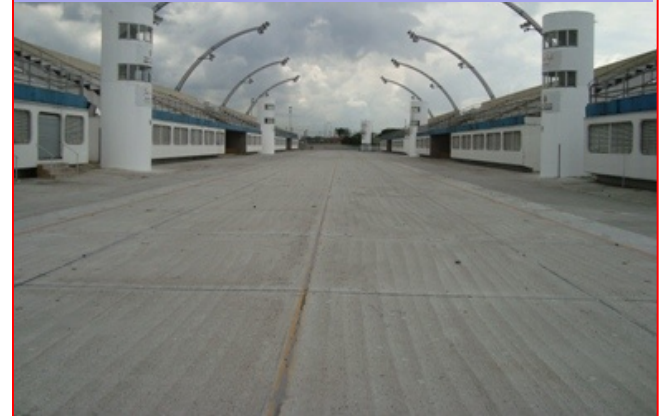
Condição Inicial do pavimento em concreto fresado
