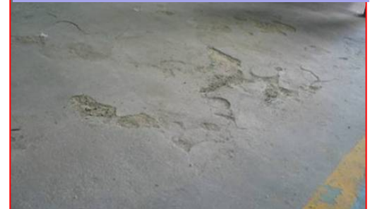
Condição Inicial de piso em concreto de garagem
