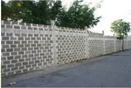
Muro do Campo – Bairro de São Geraldo – Serra/ES
