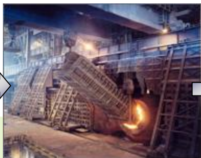
(2) Carregamento de sucata no Convertedor
