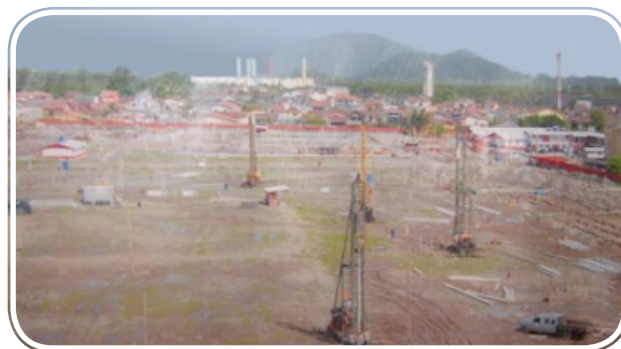
Figura 26 – Construção dos pilares de concreto em dezembro de 2010
