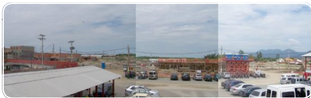
Figura 25 – Canteiro de obras no conjunto Rubens Lara em fevereiro de 2010
