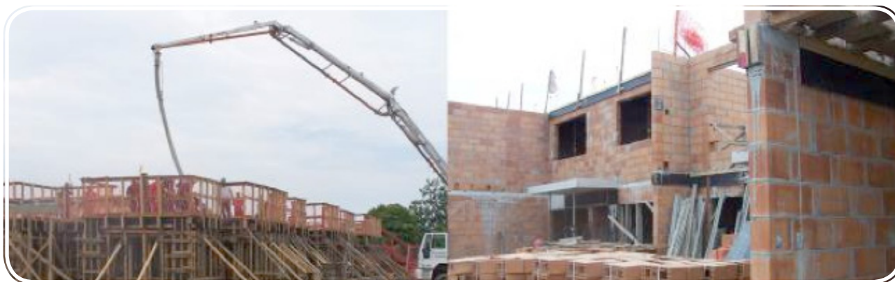
Figura 27 – Construção do conjunto Rubens Lara
