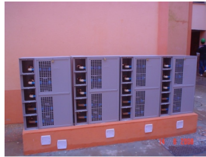
Figura 4.2 – Abrigos metálicos no andar térreo
