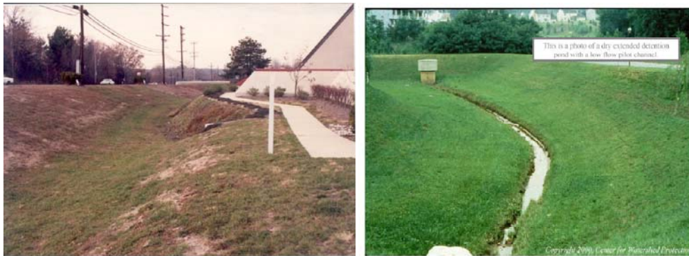
Figura 5.1 – Reservatório de detenção estendido localizado no Estado da Pennsylvania
